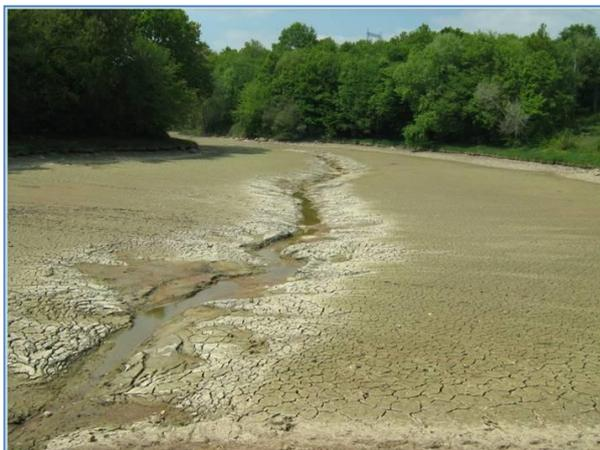
Vue de la retenue après rupture de la vanne de fond (avril 2010)
