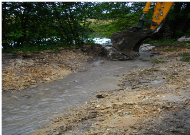
Phase 3 :Création d'un bras de contournement du Moulin de Bury – déversoir d'alimentation de la ZH
