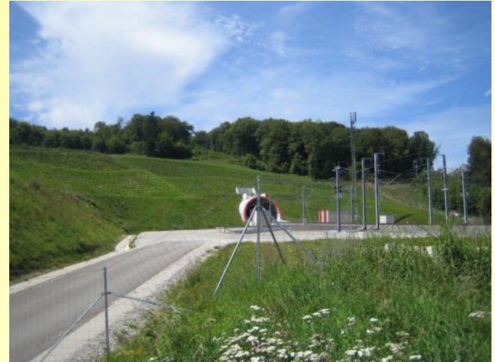
LGV : Tunnel de Chavanne
