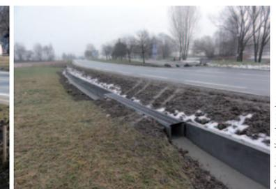
Détrier - RD925 • Dispositif de guidage latéral et
