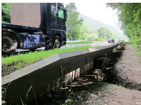
Passage à faune du Cheylas, vue sur le bavolet © A. Daloz - Aten
