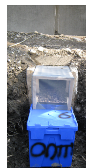
Dispositif de collecte en sortie d'ouvrage © CG38
