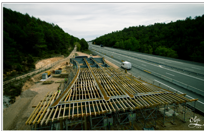
Ci-dessus : Phase de travaux sur le site de Brignoles © Olya
