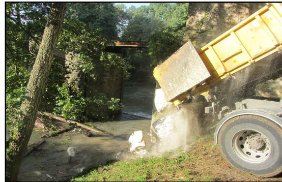
Blocs disposés en amont et aval de l'ouvrage pour créer l'effet rampe pour faciliter le franchissement piscicole
