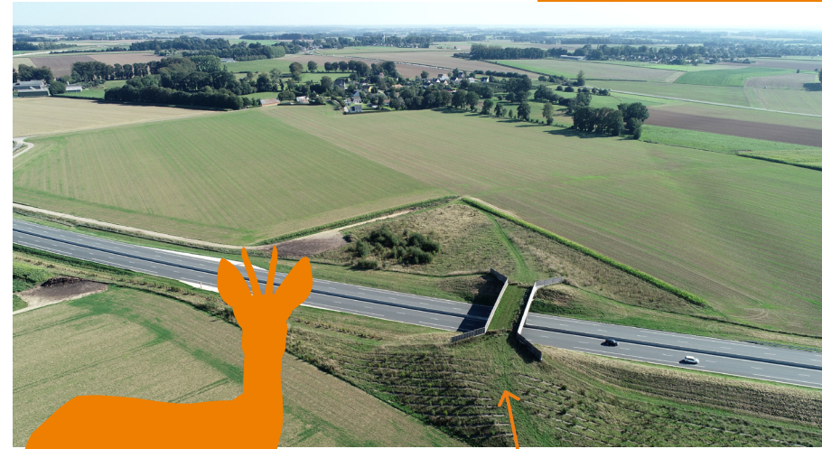
Passage multifonction au-dessus d'une autoroute : il permet aussi bien la circulation de promeneurs que le passage des chevreuils... et des cloportes.
