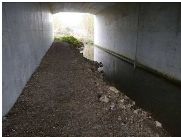
L'ouvrage du Bois de Brestel (5 m de largeur, 26 m de longueur), comprenant une banquette pour la faune terrestre. © O.G.E.-V. Vignon.
