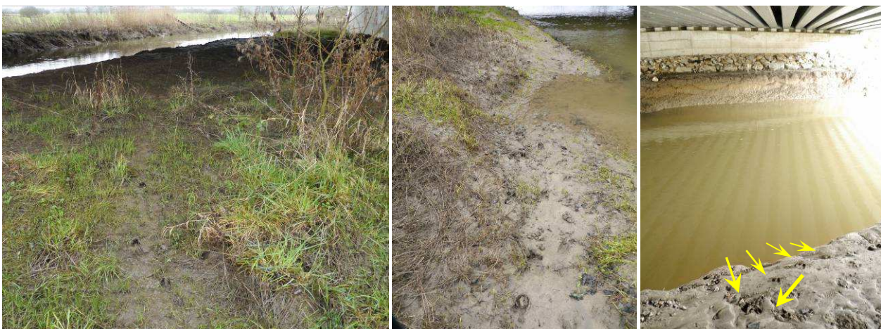
Le 10 janvier 2013, les traces d'un cerf qui a tenté la traversée aux deux extrémités de l'ouvrage refusant deux fois après être entré de plusieurs mètres sous l'ouvrage. Un autre cerf a fait la même tentative et marqué un refus sous l'ouvrage de l'autre côté de l'autoroute à la même période © O.G.E.-V. Vignon.
