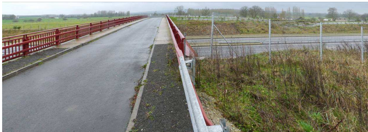
RN12 à l'est du méandre de la Sarthe, un ouvrage routier qui peut être élargi et réaménagé en passage mixte pour la faune et la desserte d'une maison au lieu-dit « les Epinay », le 10 janvier 2013. Cet ouvrage est situé sur l'ancienne voie de déplacement des cerfs et des sangliers entre la forêt de Perseigne et le bois de Bourse © O.G.E.-V. Vignon
