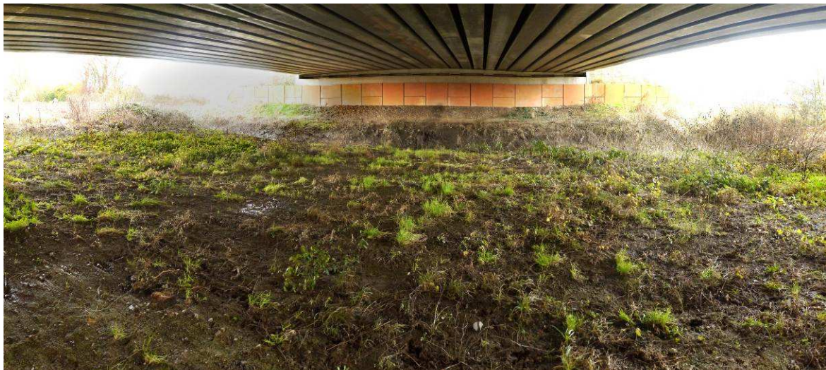
1 ère travée/6 à l'extrémité ouest – 30 m de largeur, le 10/01/2013. La végétation s'est développée sous l'ouvrage, notamment grâce à l'abondance de l'eau (inondation hivernale et humidité de la vallée).
