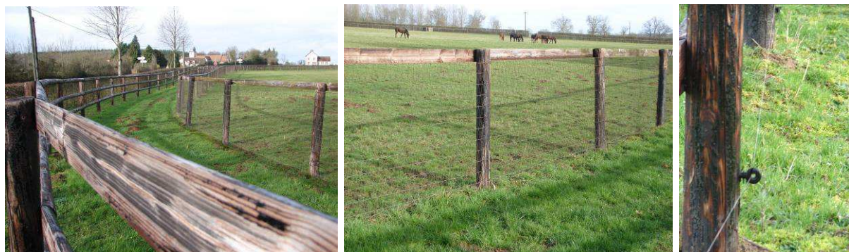
Double clôture en bois avec un fil électrique à hauteur de sanglier sur l'extérieur et un grillage complet sur l'intérieur. Le dispositif ne permet pas le passage de la grande faune, le 31 janvier 2013 © FDC61.
