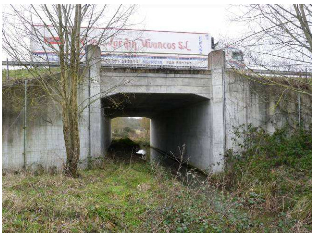
L'ouvrage du Bois de Brestel (5 m de largeur, 26 m de longueur), comprenant une banquette pour la faune terrestre. © O.G.E.-V. Vignon.
