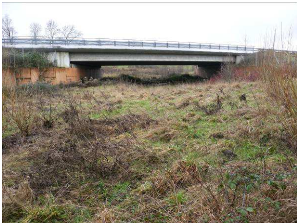
Passage faune inférieur spécifique de 20 m de largeur.
