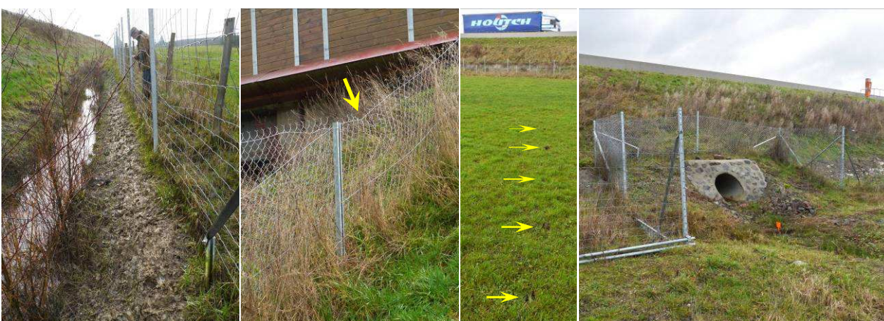
Le 10 janvier 2013, des traces récentes de cerfs/biches entrés dans les emprises de la RN12. Les animaux ont cherché une sortie piétinant le pied de clôture (photo de gauche) pour finalement sortir par dessus le grillage losange et souple placé sur les montants du passage faune (flèche sur la seconde photo). De nombreuses traces de cerfs/biches de part et d'autre de la RN12 comme ici cette biche qui court droit sur la clôture pour s'arrêter au pied de clôture (flèches pointant les traces de course sur la troisième photo). Sur la photo de droite, la clôture losange qui contourne la buse est basse, moins de 1,20 m, facilement franchissable par un cerf ou une biche.
