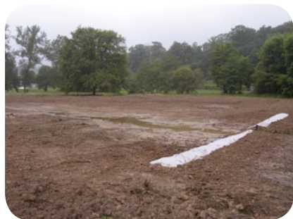
Réalisation du bassin aval de décantation
