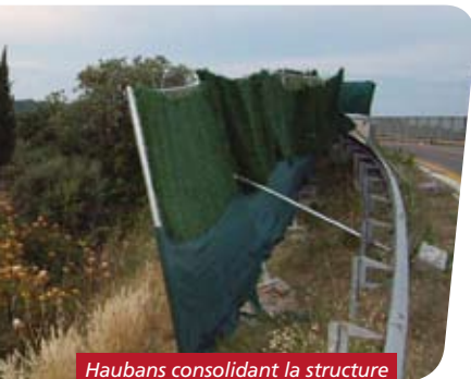
Haubans consolidant la structure contre le vent. © S. Fourasté
