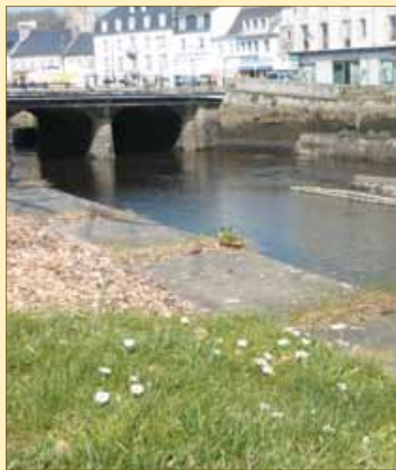
Continuité du cours d'eau au travers de la ville
