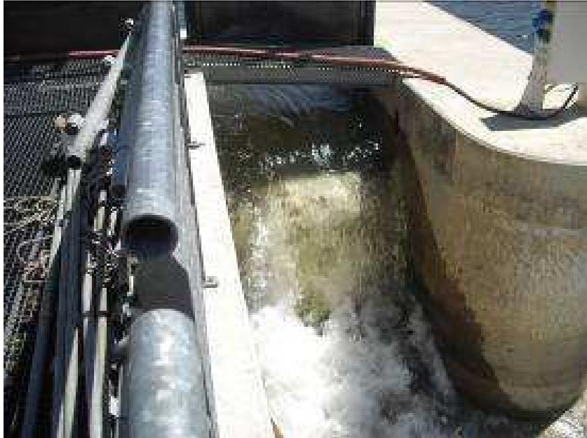
Figure 1 : Exemple de déversoir rectangulaire dénoyé.
