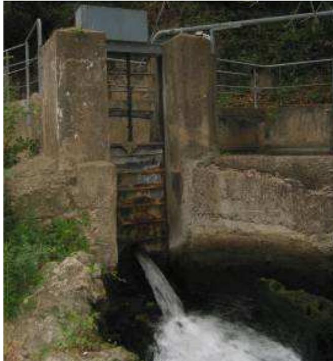
Figure 9 : Exemple d'orifice à forte charge dénoyé à l'aval.
