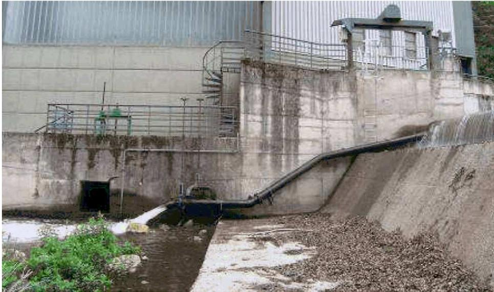
Figure 17 : Exemple de conduite en charge par syphon.
