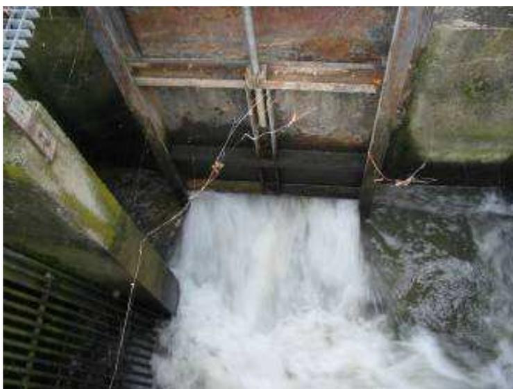
Figure 14 : Exemple d'écoulement sous une vanne de fond
