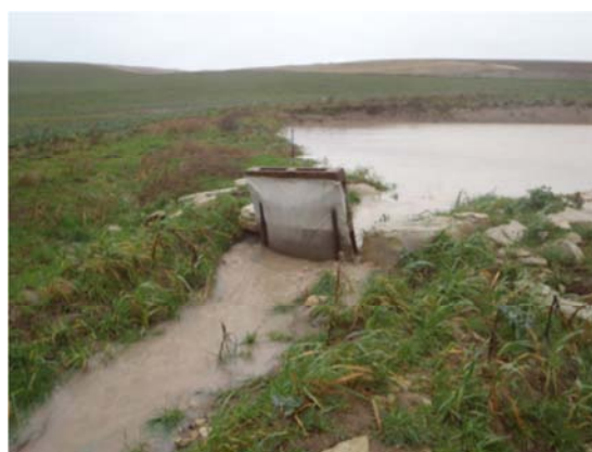
⊗ Débordement avant traitement des eaux, lié au sous dimensionnement du bassin (Source : Onema)
