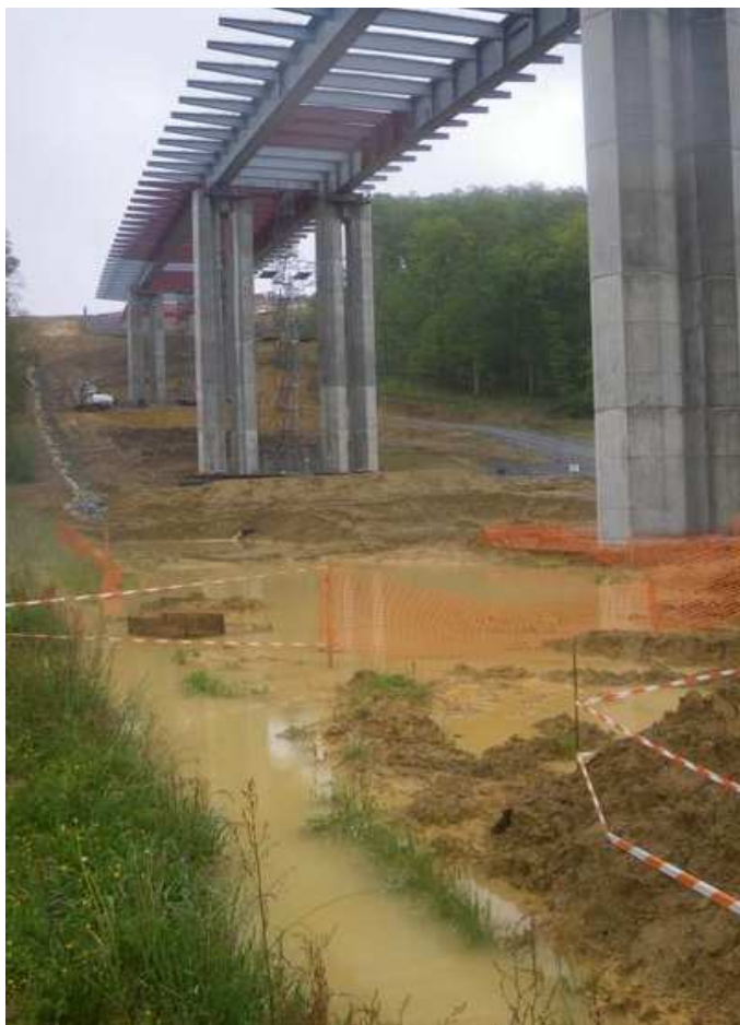
⊗ Ruissellement et départ massif de matière en suspension sur terres mises à nu non protégées de l'érosion (Source : Onema)
