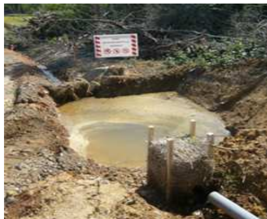
⊗ Bassin de décantation sous-dimensionné et filtre à paille non fonctionnel
