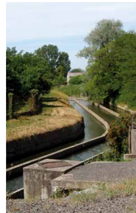
Joze (63) - Canalisation sur le Bédât.
