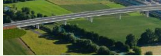
Franchissement canal de la Marne au Rhin
