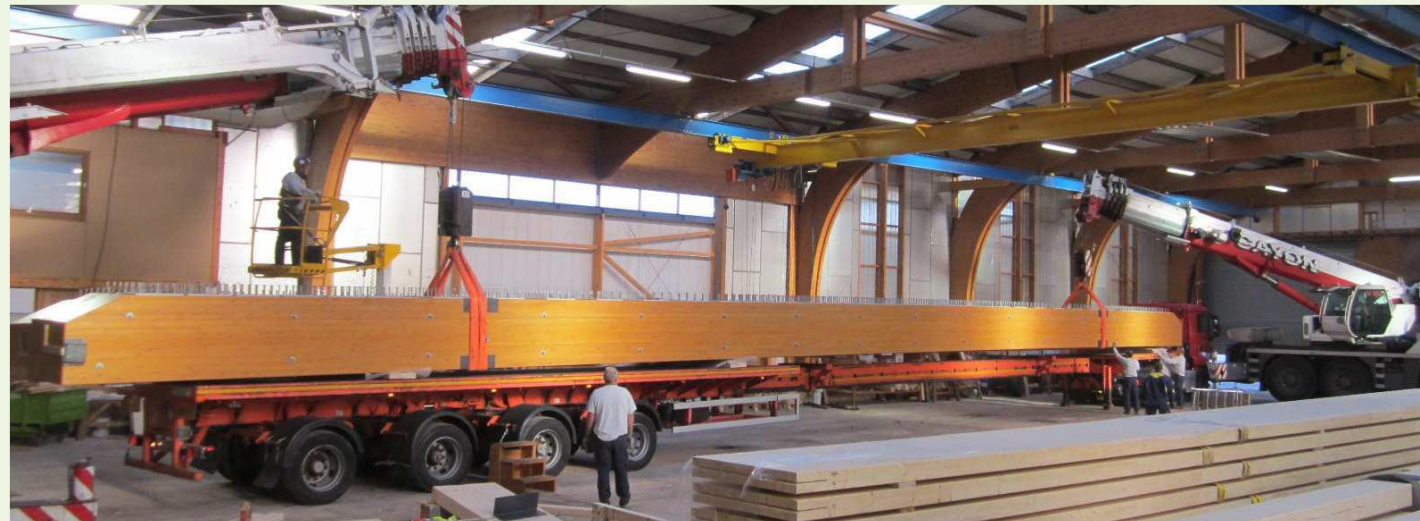
2 poutres de 24 tonnes
