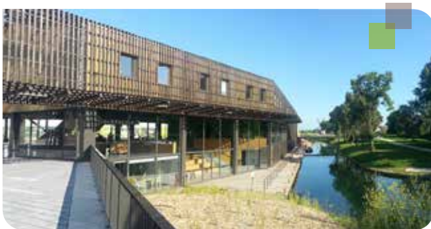
Maison du Marais en travaux - Juillet 2014
