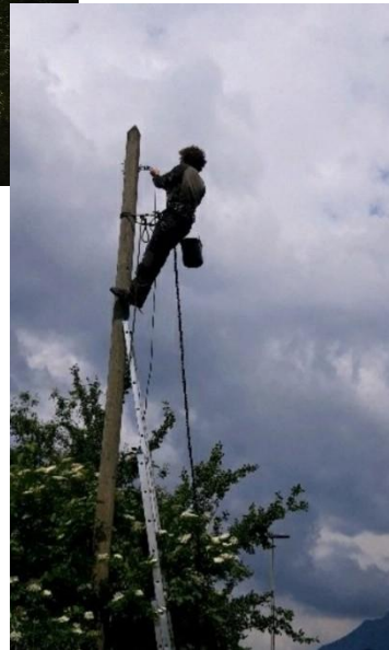
Pose d'un écuroduc à Eybens ©A. Atamaniuk
