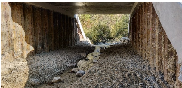
Figure 2 : planche photos du déroulement des travaux de suppression de la buse de Tacon. (photos Département de l'Ain)
