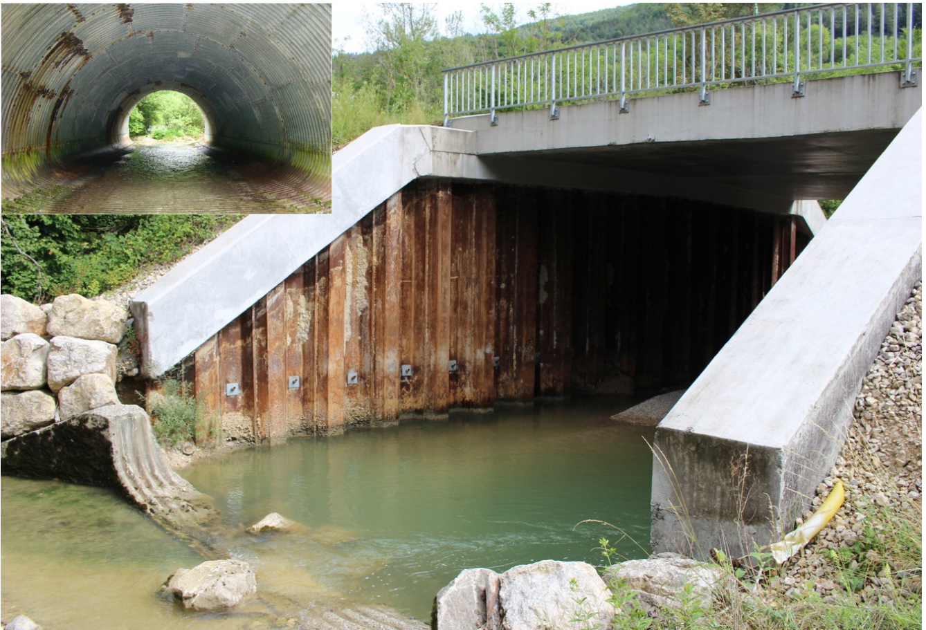
Figure 1 : Ouvrage de franchissement du Tacon, vue de l'amont État initial en haut à gauche, après travaux en 2022 en bas à droite Photos Département de l'Ain – Cerema Centre-Est
