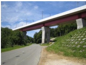
Photo 10 : Viaduc du Pertuis
