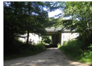
Photo 9 : Chemin agricole sous l'A36
