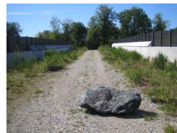
Photo 11 : Passage faune sur la route E54
