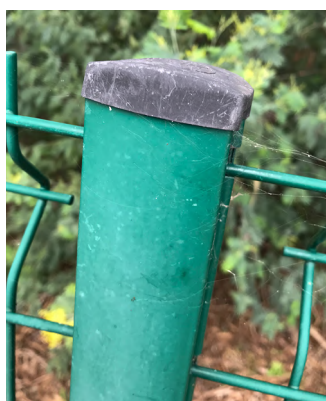
ill. 93. Certains capots simplement emboîtés peuvent s'arracher.
