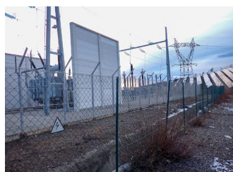
ill. 70. Double clôture au droit d'un poste HTB. À l'intérieur d'une clôture d'exclusion générale en grillage souple simple torsion, le poste est sécurisé par un grillage semi-rigide rehaussé par un bavolet à 3 rangs de barbelés et monté sur des plaques de soubassement en béton.
