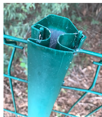
ill. 93. Certains capots simplement emboîtés peuvent s'arracher.
