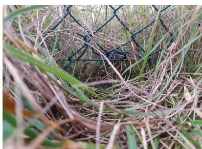
ill. 108. Coulee sous un grillage simple torsion. Ici, les picots ont été relevés pour ne pas causer de blessures. (photo : © LUXEL)
