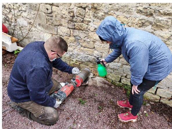
ill. 37. Carottage d'un trou de 15 cm de diamètre au pied d'un mur pour libérer un passage à hérissons.
