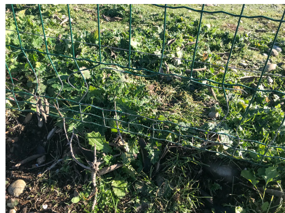
ill. 65. Clôture souple endommagée lors du fauchage à la débroussailluse à dos.
