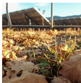
ill. 107. La garde au sol des grillages facilite le déplacement des animaux. (photos : C. Buton)
