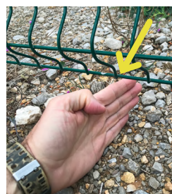
ill. 107. La garde au sol des grillages facilite le déplacement des animaux. (photos : C. Buton)
