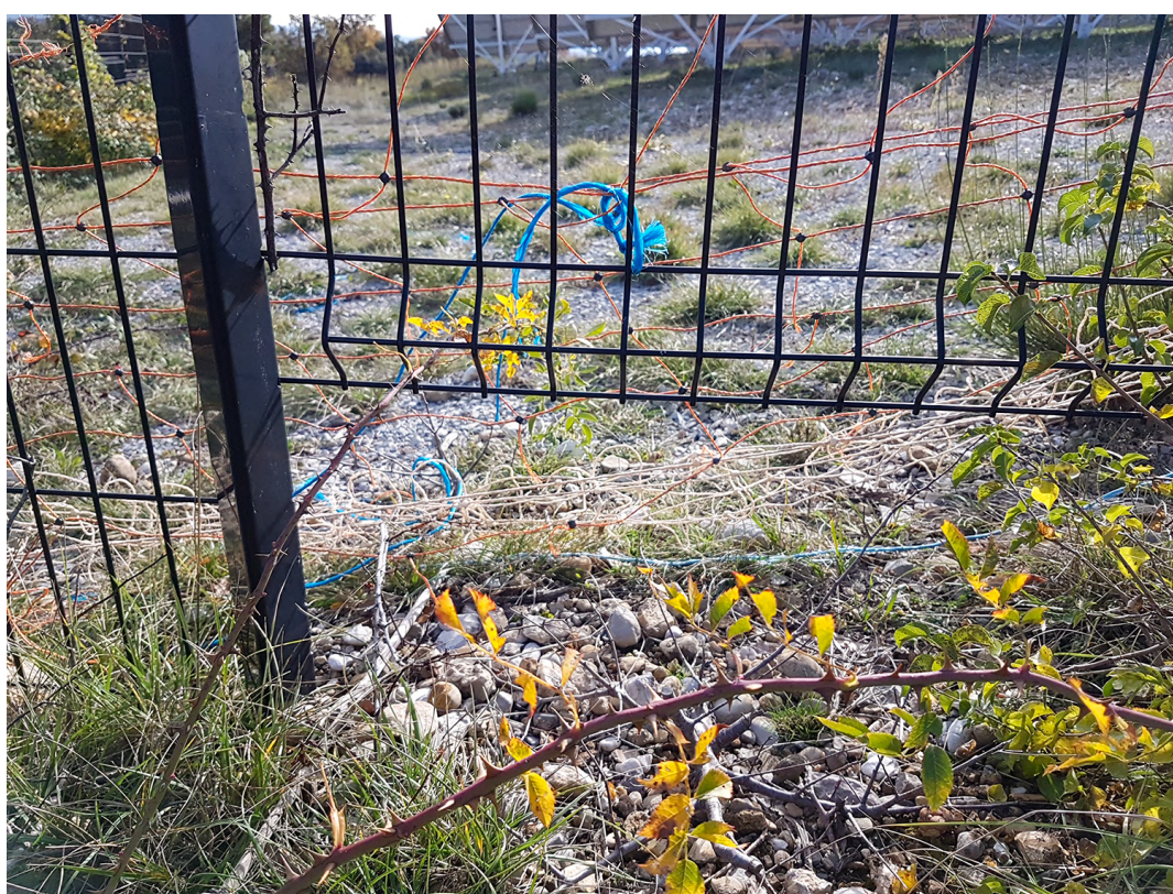
ill. 79. Filet souple colmatant un espace sous le grillage. (photo © Auddicé Environnement)
