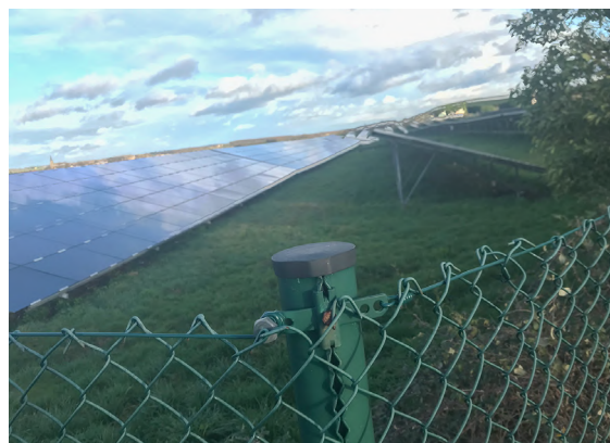
ill. 97. Exemple de grillage simple torsion avec des fils aboutés en partie haute et des poteaux capotés. (photo : C. Buton)
