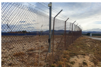
ill. 39. Exemple de barbelés constituant un bavolet sur la clôture d'un ancien terrain militaire réaménagé en CPV.
