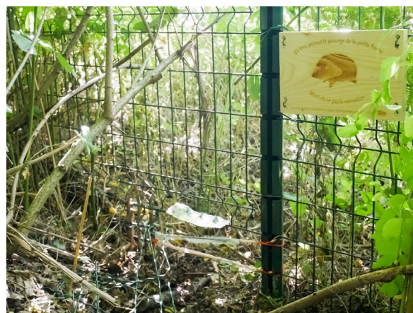
ill. 123. Passage à faune découpé en pied de clôture rigide avec sa plaquette informative et son système de collecte de poils.
