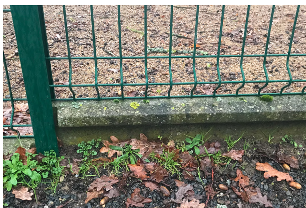
ill. 120. Le recours aux soubassements béton doit être limité ou accompagné de passages pour la faune si les contraintes de sécurité sur le site le permettent. (photo prise hors contexte CPV : C. Buton)
