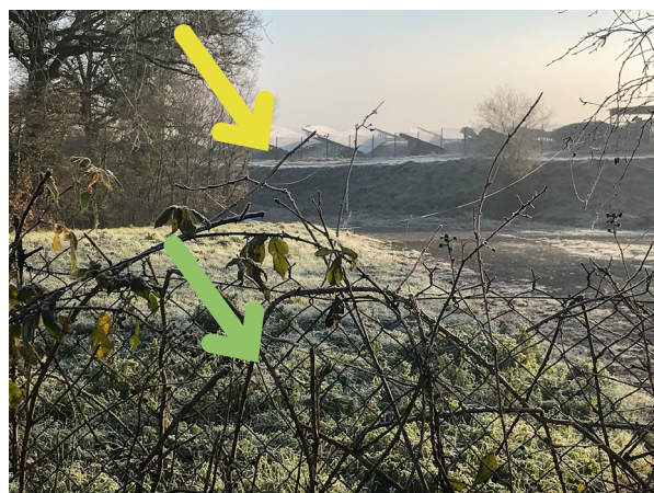
ill. 80. Exemple de clôture préexistante conservée à l'extérieur d'une nouvelle. Il s'agit ici d'un ancien centre d'enfouissement technique (déchets non dangereux) réaménagé en CPV. (flèche verte : ancienne clôture, flèche jaune : nouvelle clôture) (photos : C. Buton)
