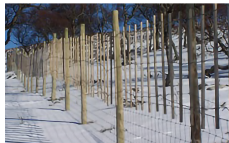
ill. 100. Exemple de clôture alliant ganivelles en bois et grillage recommandée en Écosse afin de limiter les collisions de grand tétras ou de coqs de bruyère.
