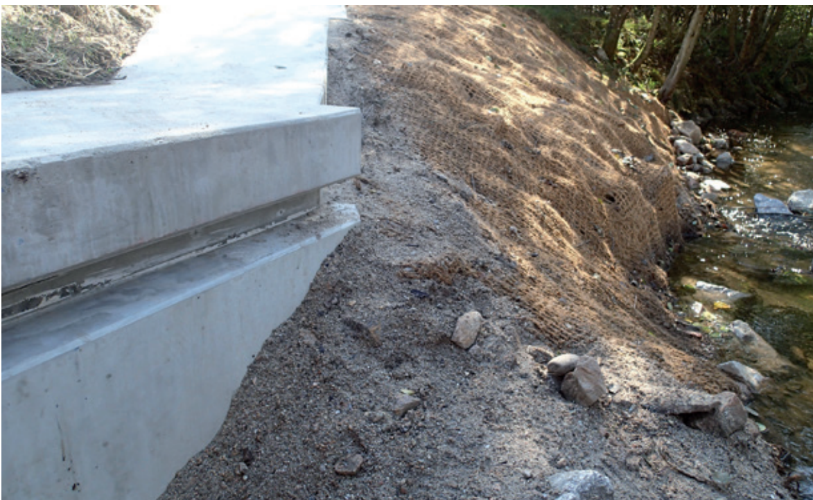
Planche-photos 1 : Illustrations de l'ouvrage et son réaménagement pour la petite faune (photos prises en phase chantier). © GREGE Haut : Vue générale de l'ouvrage du Deiro - Bas : Aperçu de la banquette faune et de l'encoche « micromammifères » créées et de leur raccordement à la berge en aval.
