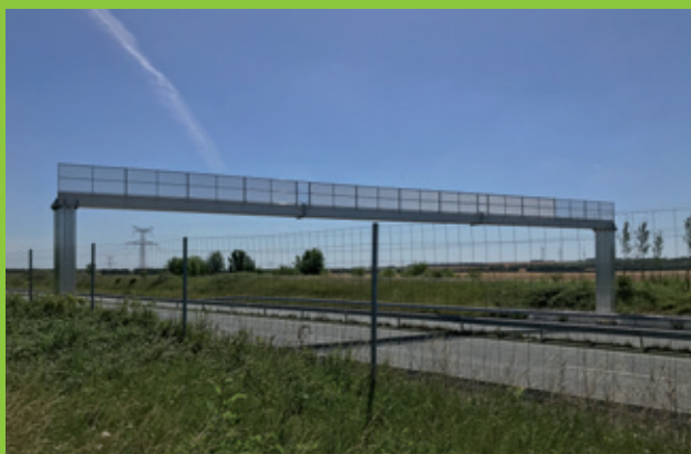
Figure 18 : Ouvrage dédié avec une grille dimensionnée pour une meilleure perception de cet ouvrage par les chauves-souris
