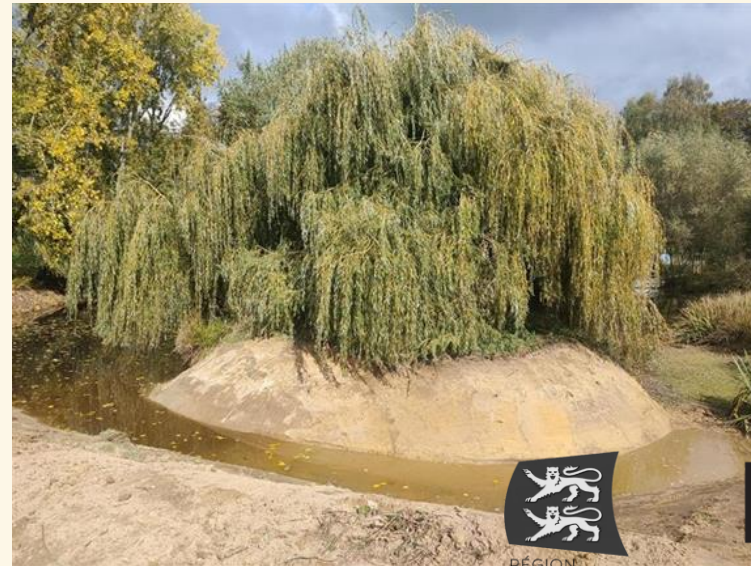
Avant et après travaux à Rouville
