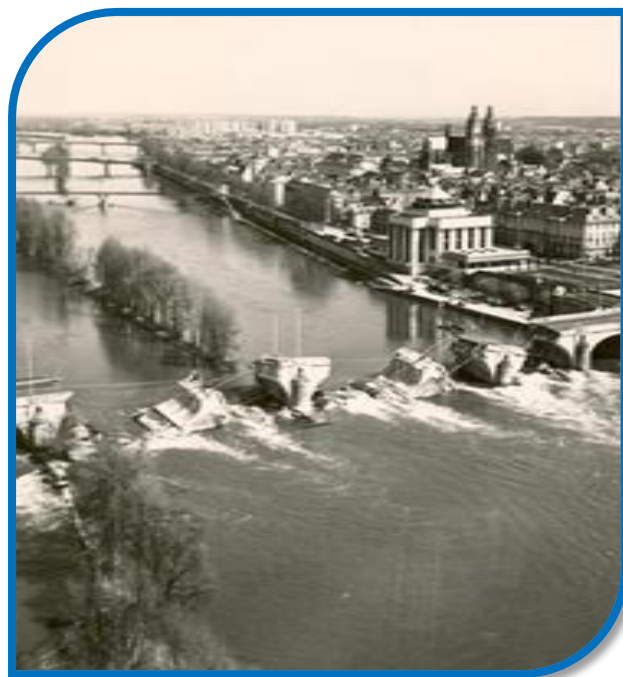
Effondrement du pont Wilson à Tours (1978)
