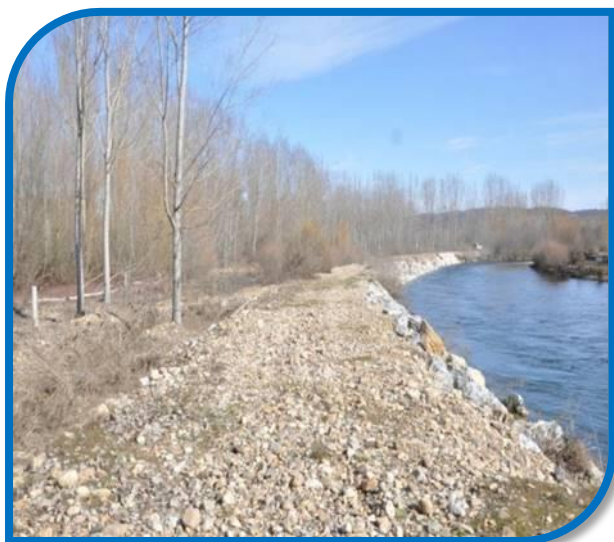
L'Orbigo avant travaux de recul de digue
