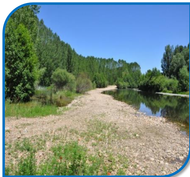
L'Orbigo après travaux
