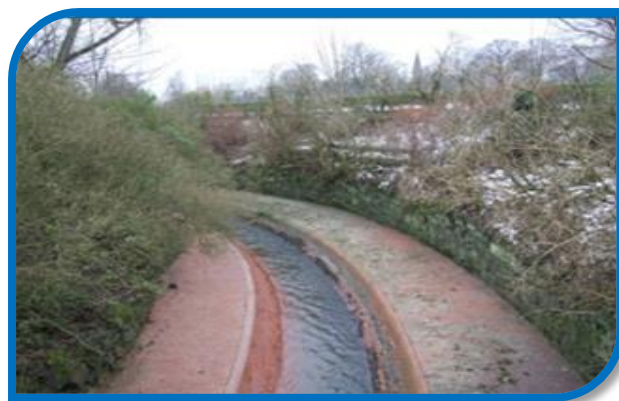
La River Medlock avant travaux
