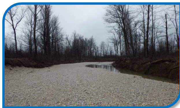
Le nouveau chenal après travaux (en haut) et après la première crue : un réajustement des berges s'est opéré et les matériaux déposés recréent une alternance de faciès
