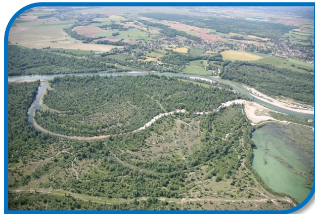
Le nouveau chenal après travaux
