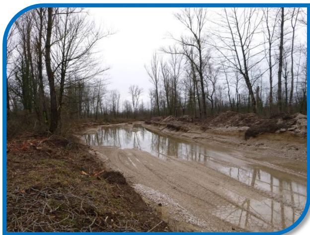
Opérations de déboisement de l'ancien chenal (en haut) et le nouveau chenal après terrassement
