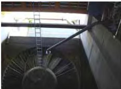
Vue du tube d'injection relié à la pièce métallique installée sur le distributeur de la VLH - © Ecogea
