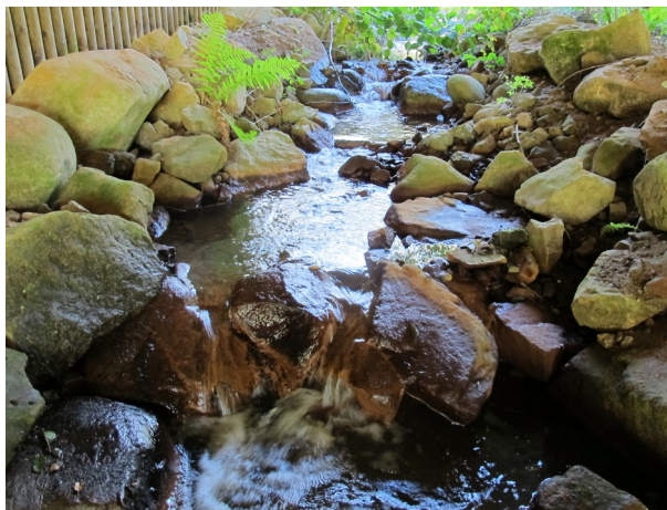
Figure 22 : Exemple de lit mineur avec fond et berges enrochés ('RN57 sur le ruisseau d'Humont') (Source : P. Mazuer, Cerema Est)
