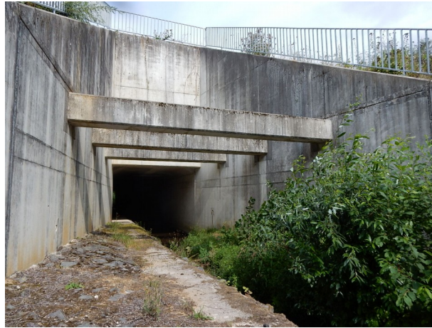
Figure 24 : Exemple de butons permettant de réduire la longueur d'un PI* (Source : P. Mazuer - Cerema Est)
