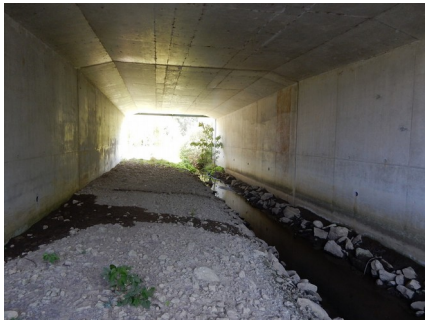
RN4 sur ruisseau de la baraque
