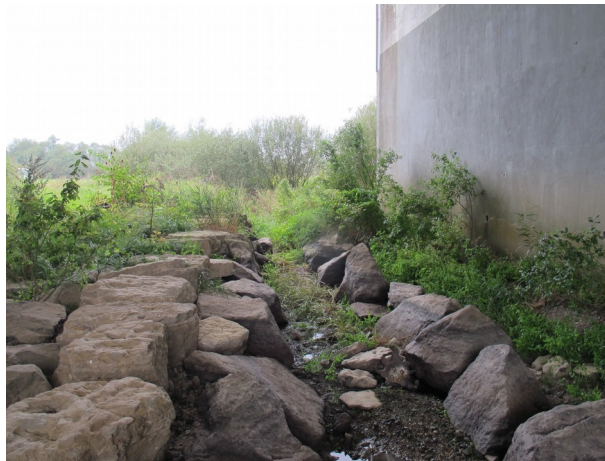
Figure 17 : Exemple de berges avec enrochement dense ('RN4 sur le r. de l'étang de Fréménil') (Source : P. Mazuer - Cerema Est)
