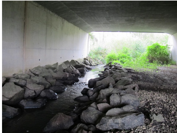
Figure 25 : Exemple de situation existante à éviter à l'avenir, autant pour la végétation terrestre (réduite aux premiers mètres des ouvertures), que pour celle des berges ou aquatique (inexistante pour ces deux dernières) : 'RN4 sur ruisseau de l'étang' (Source : P. Mazuer - Cerema Est)
