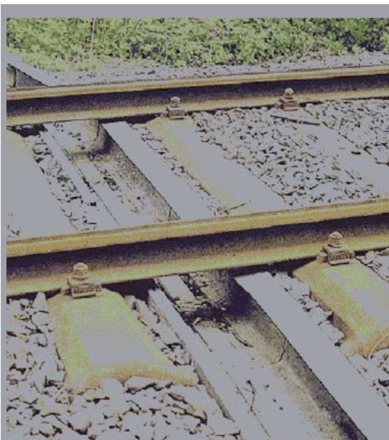
Figure 7.76 - Pour les amphibiens et autres petits animaux, une buse peut être posée sous la voie ferrée, lorsqu'il est impossible d'installer un tunnel plus large (photographie de l'auteur).
