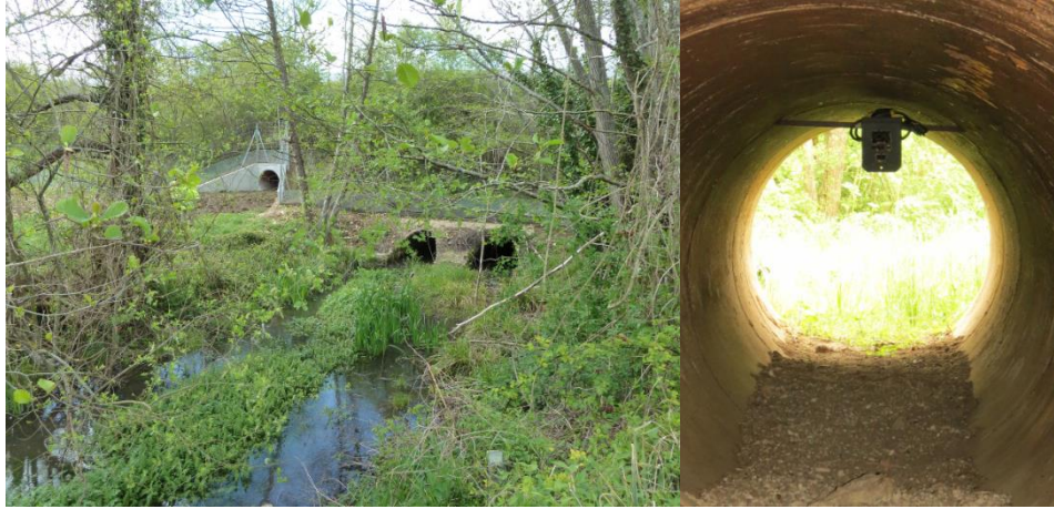
Figure 2.— (A, gauche) : Aménagement d'un passage à faune de type buse sèche le long d'un cours d'eau sur l'A10 (Charente-Maritime, France, le 24.IV.12 à la mise en service de l'ouvrage). (B, droite) Disposition des pièges photographiques à détecteurs de mouvement infrarouges à l'intérieur des passages.
