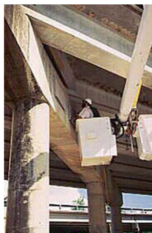
Exemple d'abri « boîte » à chauve-souris intégré aux poutres en béton d'un pont aux États-Unis.
