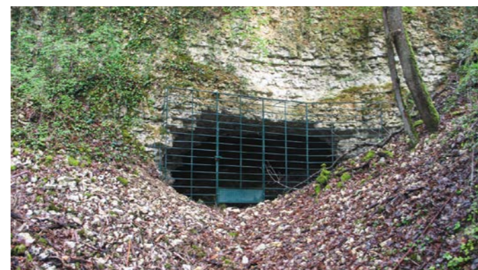
Exemples de grilles de mise en défens de carrières souterraines. Le même dispositif peut être mis en place pour les grottes et éventuels tunnels à sécuriser à La Réunion. © Épernay-agglo en haut, © MNHN en bas.
