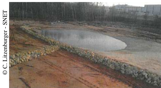
Figure 19 : Aménagement d'une mare
