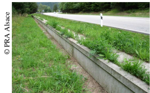
Figure 33 : Barrière en béton
