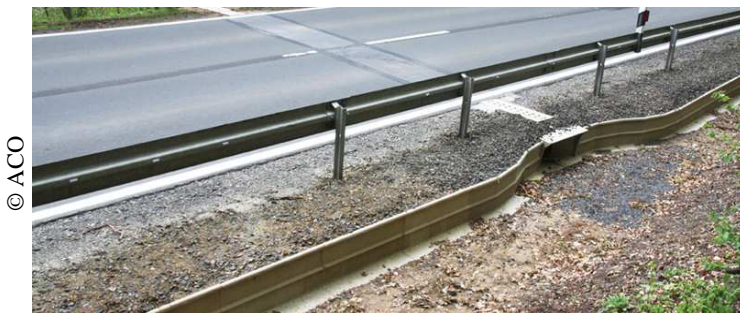
Figure 32 : Barrière associée à un passage
