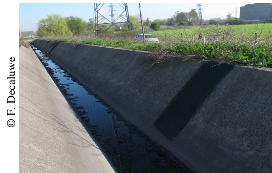
Figure 30 : A éviter : le fossé de décantation pollué n'est pas clôturé et l'échappatoire ne va pas jusqu'au fond.
