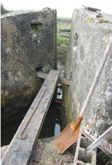
Batardeau posé dans une essaille dans le Marais Talmondais (Photo : A. Baisez LOGRAMI)
