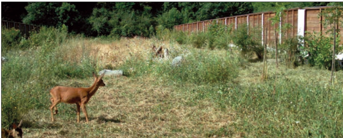
Photo n°56 : Écopont de l'A7 (© FDC 26, VINCI Autoroutes).
