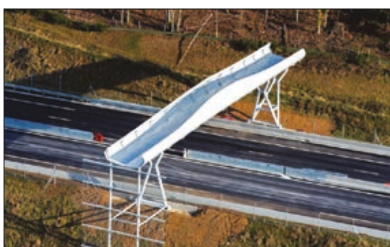
Photo n°6 : Chiroduc sur l'A89. (© VINCI Autoroutes)
