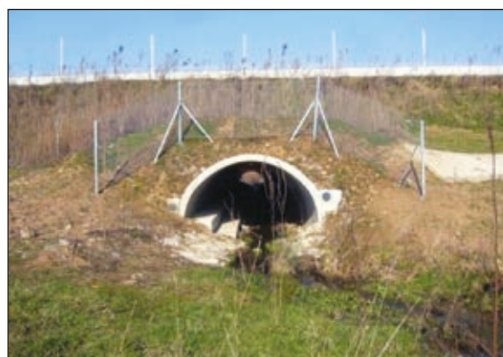
Photo n°51 : Banquette préfabriquée sur l'A89. (©EGIS).
