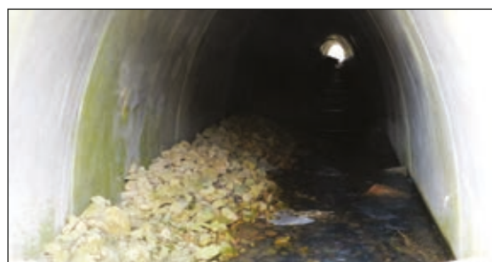
Photo n°49 : Enrochement sur l'A89. (©FRAPNA Loire).
