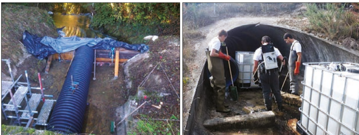
Photos n°27 : Dérivation par busage et batardeaux (on note la matérialisation du raccord à la berge sur la photo), pêche électrique préalable réalisée par une FDPPMA (de gauche à droite). (© VINCI Autoroutes).
