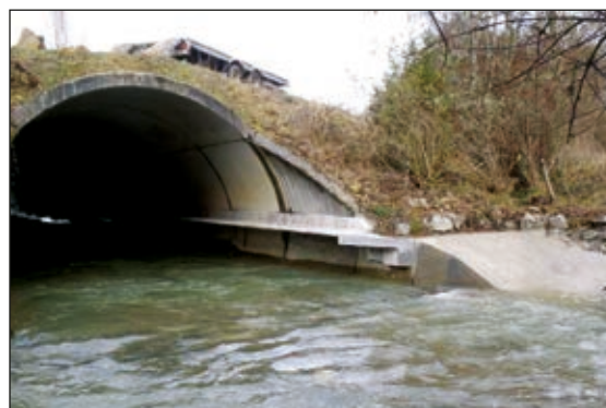
Photo n°50 : Encorbellement sur l'A64. (© VINCI Autoroutes).
