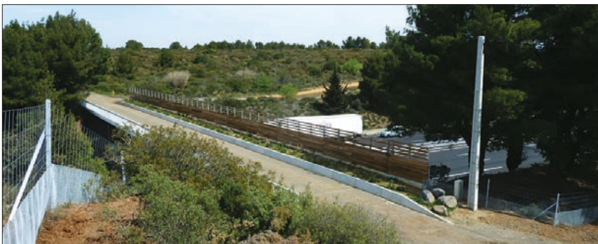
Photo n°63 : Passage mixte supérieur sur l'A9. (© VINCI Autoroutes).
