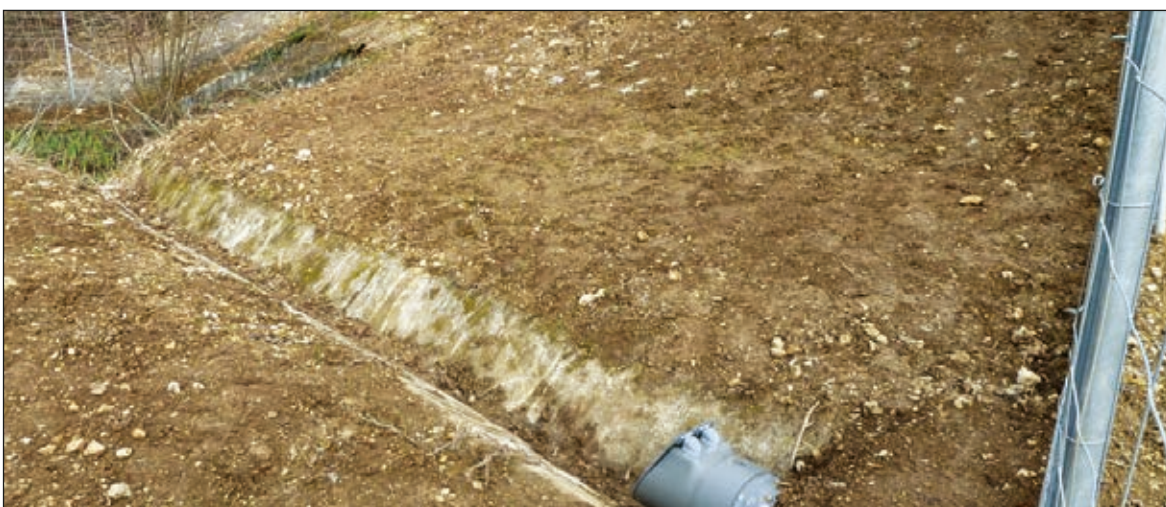
Photo n°19 : Dispositif de type clapet adapté dans certains cas uniquement (clôture franchissant un fossé). (© VINCI Autoroutes).
