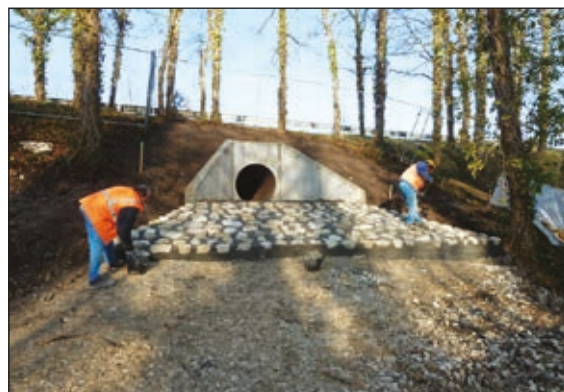
Figure n°4 : Schéma de principe d'une rampe (gauche) et réalisation d'une rampe maçonnée avant recouvrement de terre. (© VINCI Autoroutes).
