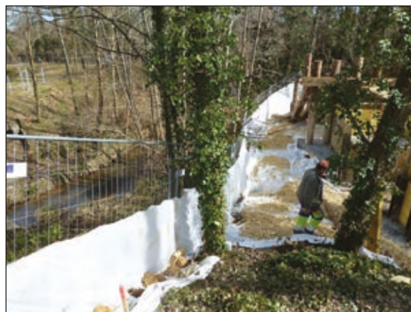
Photos n°20 : Plateforme de travail sur le chantier de l'écoduc de la Marguerite (A10) avec groupe électrogène sur un double fond bâché et géotextile conforme aux recommandations (gauche). À noter la proximité avec le cours d'eau et la conservation de certains arbres sur la zone (droite). (© VINCI Autoroutes).
