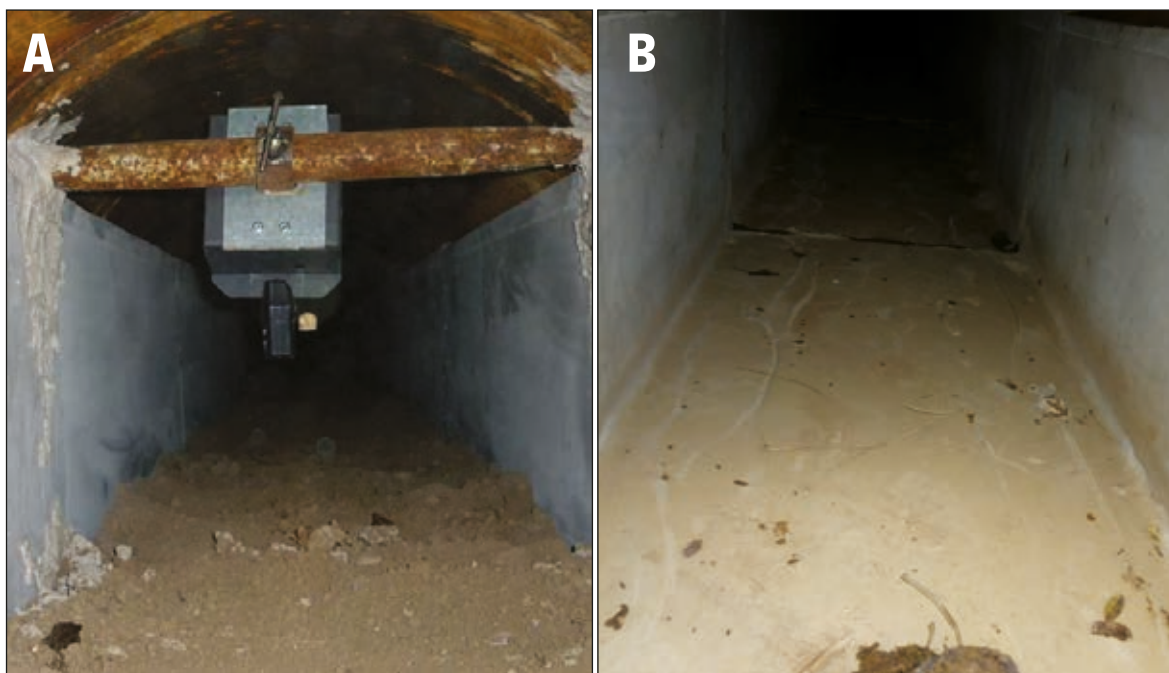
Photos n°77 : Ouvrage avant (A : avec substrat) et après (B : sans substrat) la crue. (© LPO Drôme, VINCI Autoroutes).
