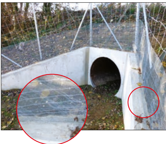
Photos n°18 : Repositionnement semi-enterré du grillage renforcé (haut), jointure au mortier du grillage autour de la tête (bas). (© VINCI Autoroutes).
