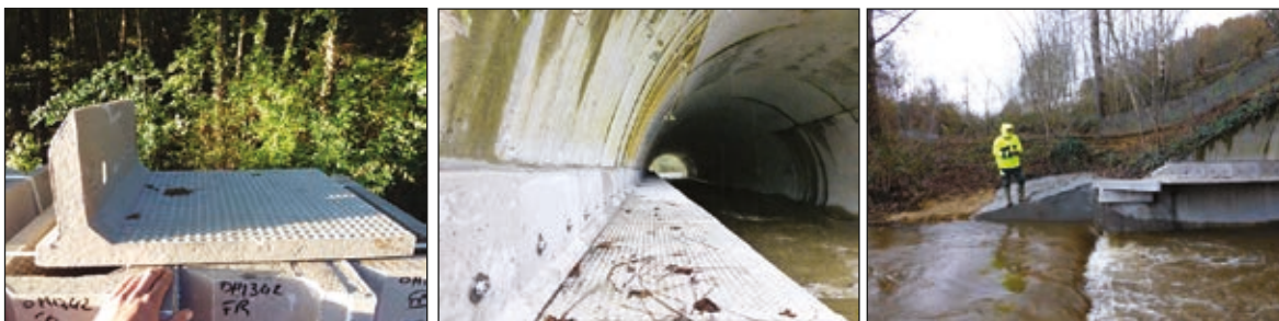
Photos n°24 : Encorbellement en béton polymère, encorbellement achevé dans l'OH et raccordement offrant une possibilité de passage depuis le pied et le haut de berge et ne générant pas un point dur à l'écoulement (de gauche à droite). (© VINCI Autoroutes).
