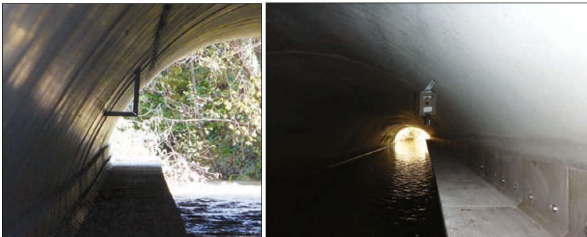
Photos n°26 : Fixation du « L » en vue du suivi écologique post-aménagement (à gauche) et appareil fixé sur une cornière simple sans possibilité de passage du câble de protection. (© VINCI Autoroutes).
