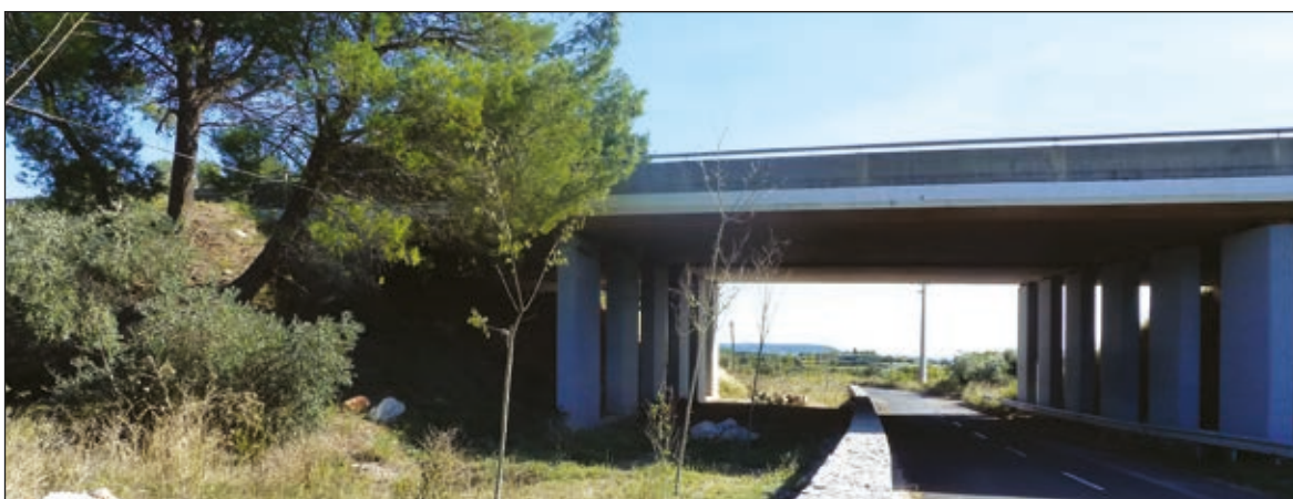
Photo n°64 : Passage mixte inférieur sur l'A9. (© VINCI Autoroutes).
