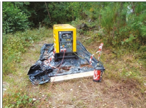
Photos n°29 : Kit anti-pollution, groupe électrogène sur cuve double fond avec bâche imperméable tout autour (de gauche à droite). (© VINCI Autoroutes).
