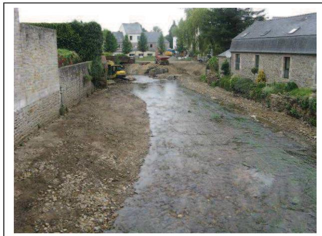
Création de bancs graveleux en berge pour réduire la section de la rivière à la largeur aval et amont. Création d'un radier stabilisé au niveau de l'ancien déversoir et comblement des trous en aval. (Importance de la stabilisation du lit en aval d'un pont et le long des murs de construction des habitations).
