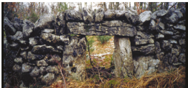
Réalisation de « fenêtres » dans le bas du linéaire des murets en pierre sèche permettant la circulation de la faune.
