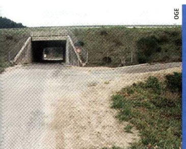
▲ Photo 2 Traces de sanglier relevées au nord du passage inférieur du chemin de la Cusmadière, le 6 janvier 2000
