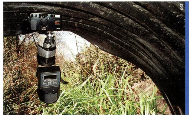
▲ Photo 3 L'appareil photographique est placé au-dessus du radar, et l'ensemble à l'entrée de la buse - Buse des Lauvets
