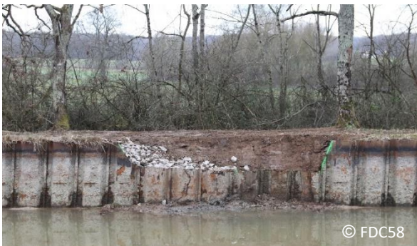
Figure 2 : Enrochement de la zone ouverte
