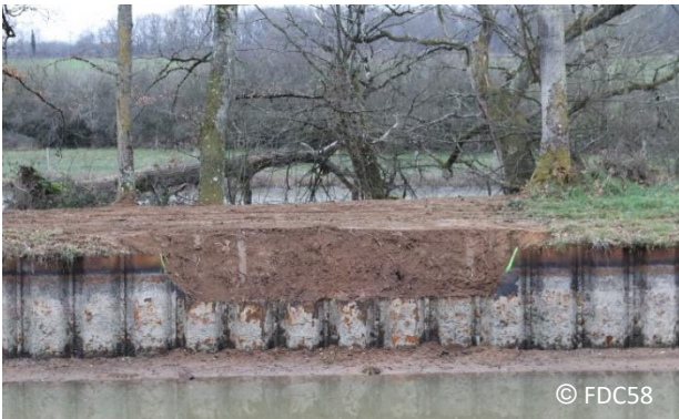
Figure 1 : Découpage des palplanches et décapage de la terre
