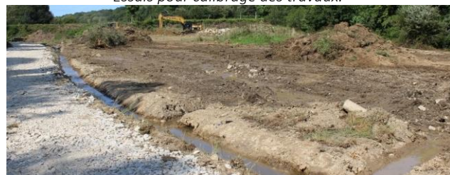
Terrain décapé et extraction des bassins de l'ancienne pisciculture.
