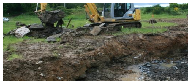
Essais pour calibrage des travaux.
